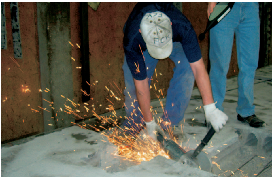
Skæring af spændbetonelementer med vinkelsliber
